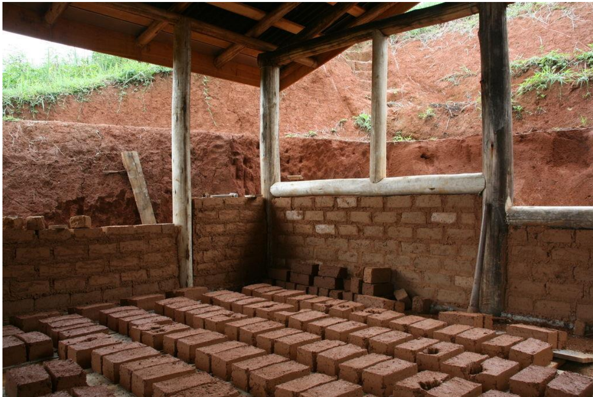
Adobes secando dentro da estrutura da casa.
