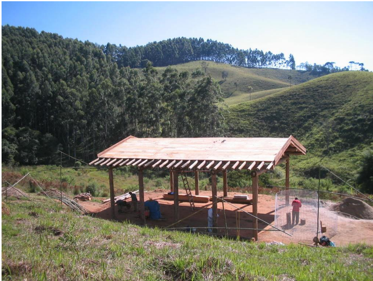
Detalhe da construção do rancho.
